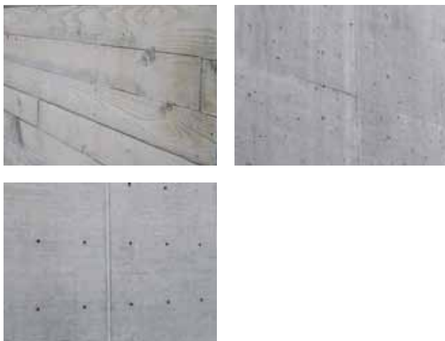
Abb. 26: Beispiele für geschlossene, weitgehend einheitliche Oberfläche mit Versatz, Graten und Rahmenabdruck der Schalung
