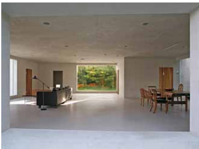
Abb. 50: Sichtbetondecke mit Einlagen für das Licht (SBK 3) Haus K+N
