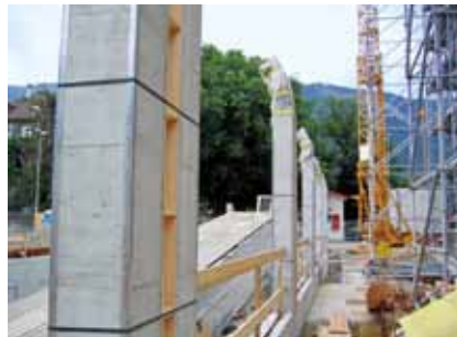
Abb. 39: Kantenschutz Stützen (scharfe Kanten)
