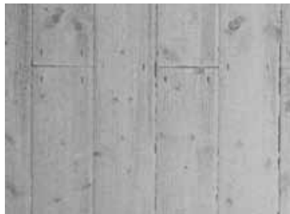
Abb. 12: 3-Schicht-Platten Beschichtung: Melaminharz
