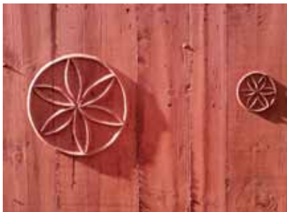
Abb. 11: Furniersperrholzplatten Beschichtung: Phenolharzfilm
