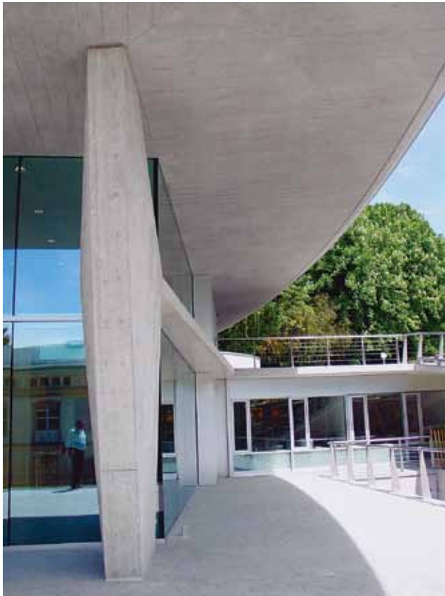
Abb. 47: Ansicht eines anforderungsgerechten Sichtbetonbaus mit Detail (Bindloch)
