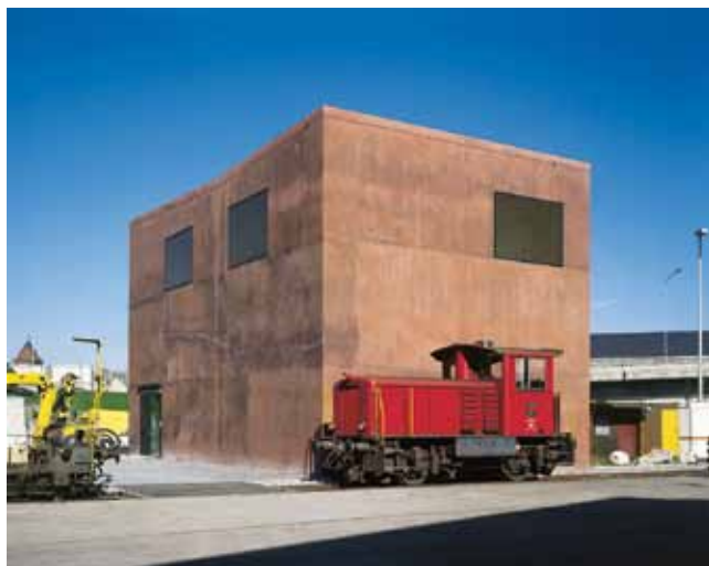
Abb. 52: «Rostiger» Beton (Foto: Stellwerk Vorbahnhof Zürich, Gigon + Guyer Architekten Zürich)
