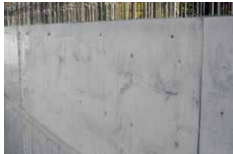
Abb. 31: Beispiele für glatte, geschlossene Oberfläche mit Hell-/Dunkelverfärbung (Wolkenbildung)
