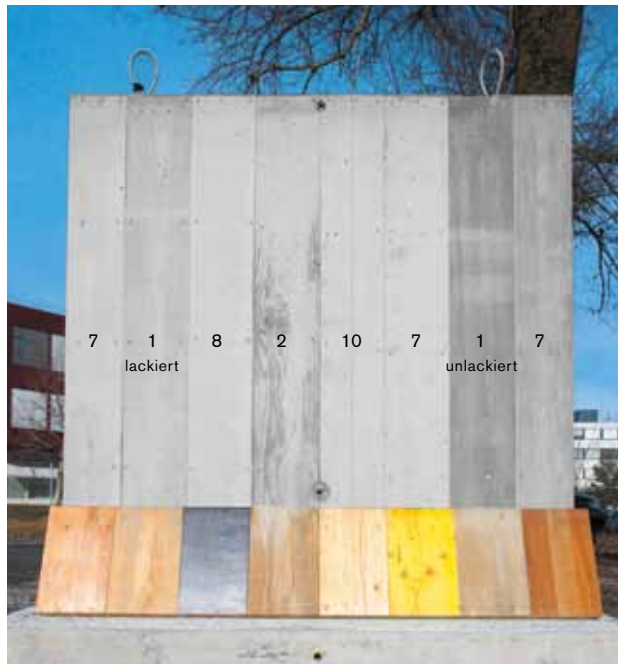
Abb. 19: Betonoberflächen mit unterschiedlichen Schalhäuten
