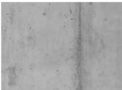
Abb. 38: Beispiel Arbeitsfuge (Wand)
