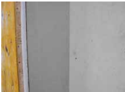
Abb. 38: Beispiel Arbeitsfuge (Wand)
