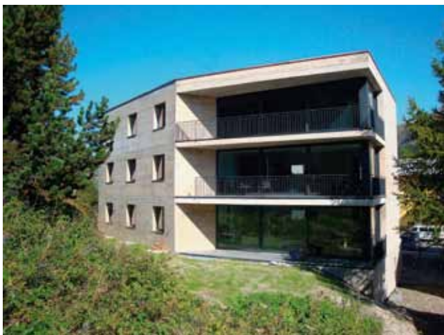
Abb. 46: Gesamteindruck eines Mehrfamilienhauses aus eingefärbtem Sichtbeton
