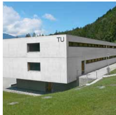
Abb. 34: Beispiele für Sichtbetonbauten mit hohen Anforderungen an die Ebenheit
